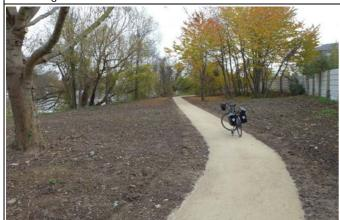
4. Malheureusement, l'aménagement ne respecte pas le cahier des charges national des voies vertes : il fait seulement 2 m de large, et même 1.5 m par endroits, au lieu de 3 à 5 m recommandés ! : cela entrainera inévitablement des conflits d'usage entre piétons et cyclistes.
