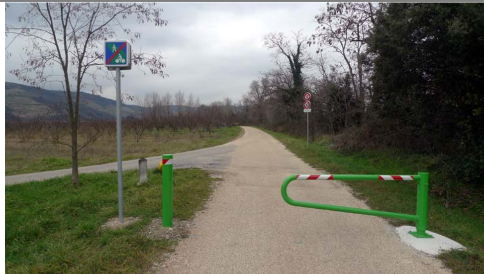
6. Demi barrière pivotante, arrondie et visible la nuit (voie verte Via Rhona à Glun, CD de la Drôme) Exemple satisfaisant.
