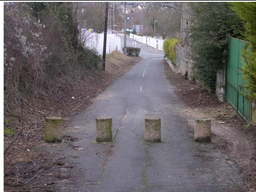
6. Plots non réglementaires (largeur inférieure à 90 cm), dangereux (très peu visibles de nuit ou pour les malvoyants) et n'empêchant pas pour autant le passage des motos ou mobylettes (Voie verte à St Michel sur Orge)
