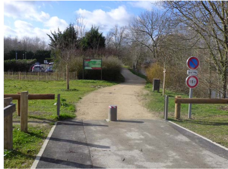
2. Plot central télescopique (voie verte de la promenade de l'Orge, à Savigny sur Orge, SIVOA) Détail : hauteur du plot non adaptée aux malvoyants, mais très satisfaisant pour le reste.
