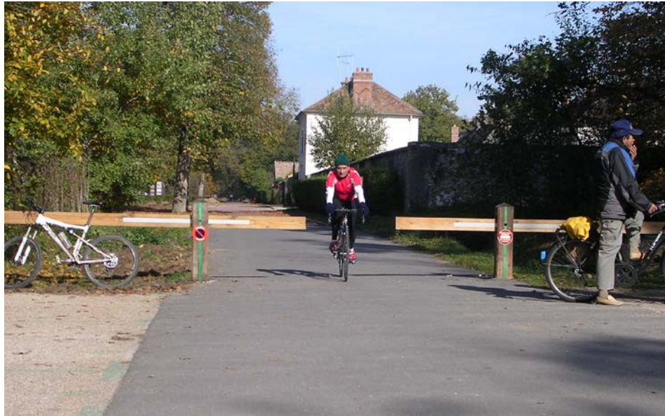
1. Demi-barrières en bois facilement amovibles, espace 1m20 (Forêt de Sénart, ONF). Inconvénient : extrémité peu visible la nuit. Poser la bande rétro-réfléchissante plus près de l'extrémité la rendrait très satisfaisante
