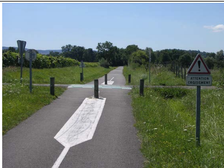
7. Plot central en bois non amovible (Voie verte n°1 de Bourgogne, près de Cluny) Inconvénient : plot non amovible (complique l'entretien) et peu visible, bien que précédé d'un marquage au sol.
