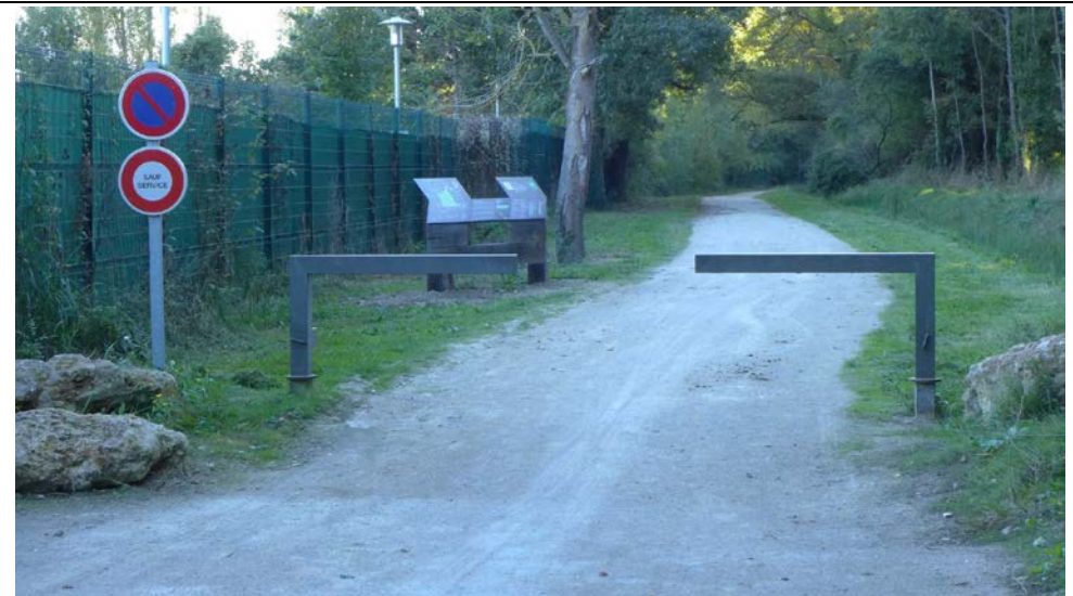
4. Double demi-barrière métallique facile à ouvrir (voie verte du Bois de St Eutrope, AEV IdF). Inconvénient : extrémité anguleuse et très peu visible la nuit : manque une bande rétro-réfléchissante.
