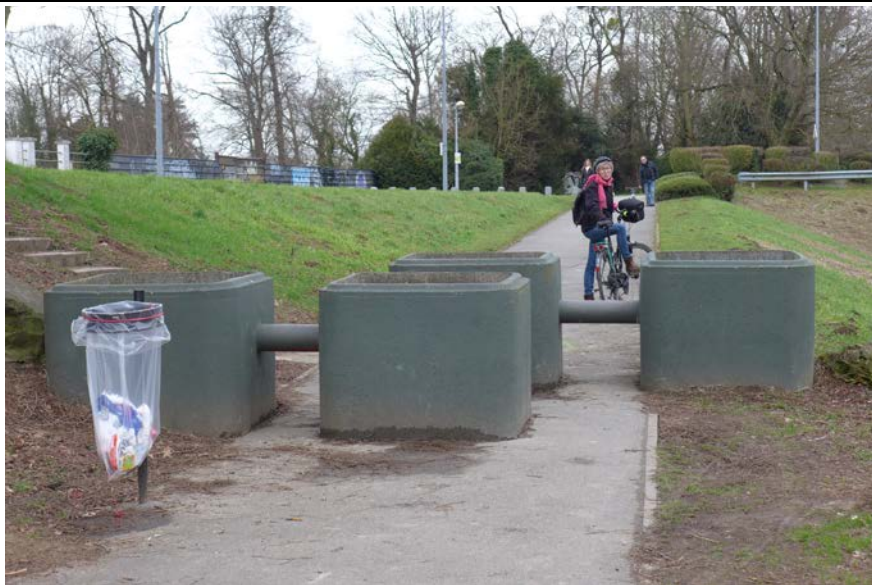
1. Chicane non réglementaire : empêche le passage de fauteuils roulants, de tricycles handicapés et vélos avec remorques. En revanche, des motos de cross peuvent passer dans le talus à droite... (ex Tégéval à Villecresnes, en cours de démontage)
