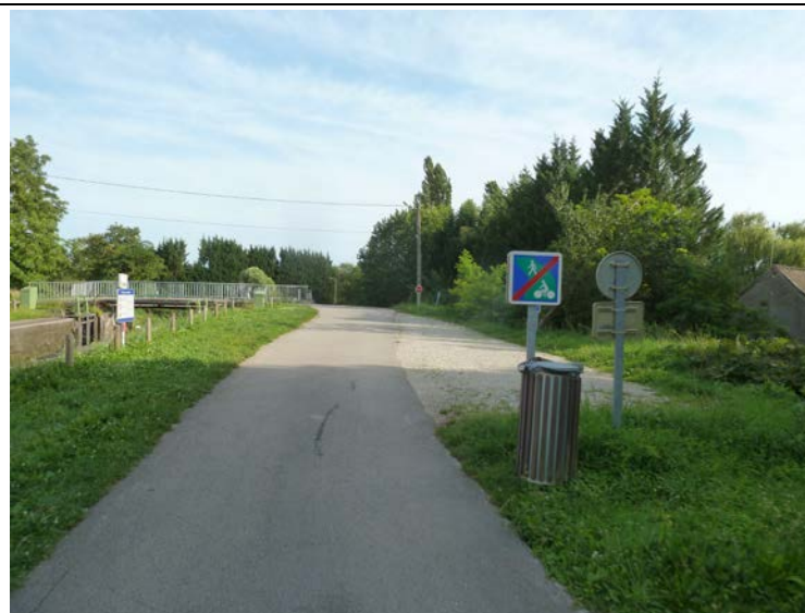
8. Le plus simple, le plus sécurisant et le moins cher : de simples panneaux début et fin de voie verte aux intersections (voie verte du Canal du Centre entre Chagny et Chalon-sur-Saône).
