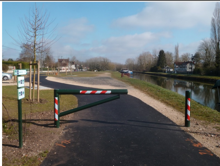
3. Demi-barrière facile à ouvrir et arrondie à l'extrémité (EV3 Scandibérique à Cepoy, CD du Loiret). Inconvénient : extrémité peu visible la nuit
