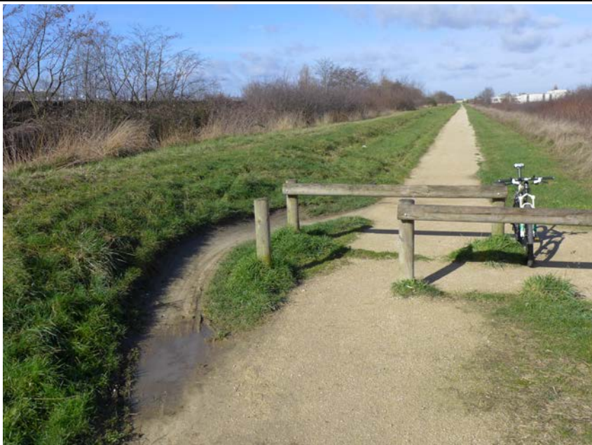
5. Chicane inutile et gênante : l'espace de 1.2 m entre les barrières permet difficilement le passage des tricycles (certains ne passent pas), incite les vélos à passer dans la boue à côté et n'empêche en rien les 2RM (Voie verte de l'aqueduc de la Vanne, à Grigny)
