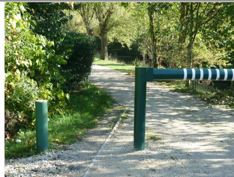
4. Barrière accidentogène : la largeur laissée sur le côté (environ 90 cm) est théoriquement suffisante pour les fauteuils et tricycles, mais en pratique trop limite (1 m 20 recommandés) et surtout, la bordurette longitudinale est un piège délicat à franchir à vélo (chutes fréquentes)
