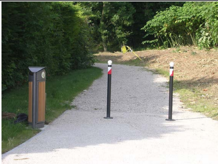
5. Double plots, hauteur et couleur conformes aux normes d'accessibilité ; largeur un peu limite entre les deux (1m10) mais suffisant et laisse la possibilité de se croiser sans avoir à s'arrêter (Berge de Seine à Evry). Exemple satisfaisant.
