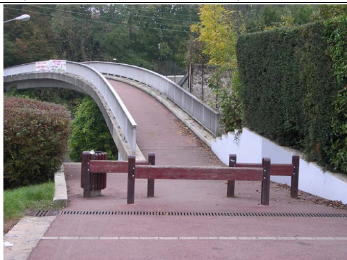
7. Chicane dangereuse (en bas d'une descente) et non réglementaire (infranchissable en tricycle ou vélo avec remorque) Ex à Juvisy
