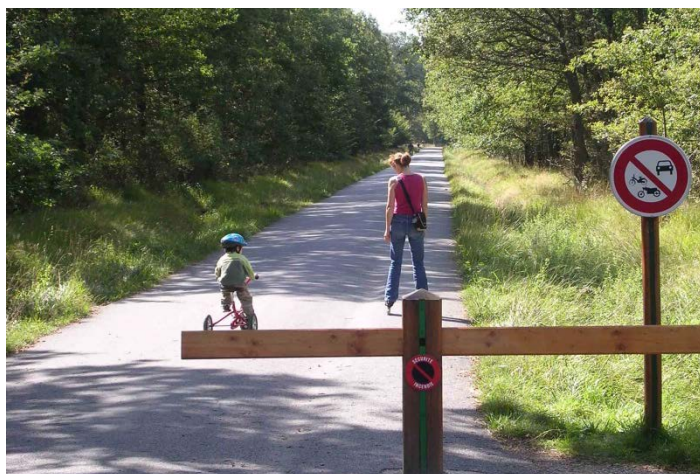
Ex 1 : enrobé avec un liant bitumineux Voie verte de la forêt de Sénart, à Soisy-sur-Seine
