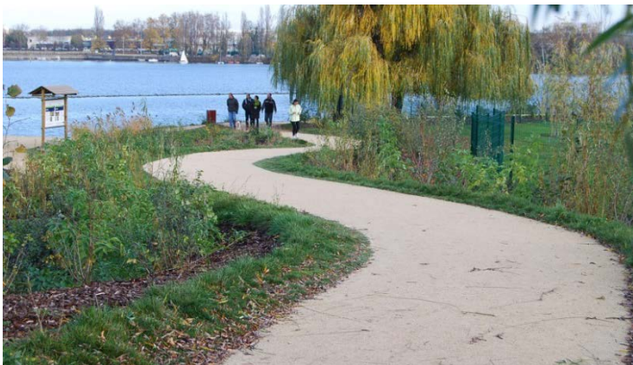
Ex 1 : voie verte des lacs de l'Essonne peu après la pose : tout nouveau, tout beau...
