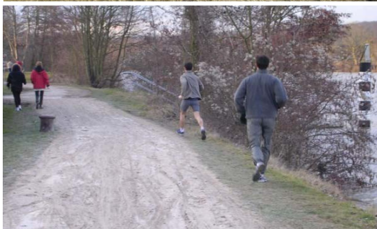
Ex 1 et 2 : sable calcaire « stabilisé » compacté Allée royale à Lieusaint (en haut) et Scandibérique à Evry
