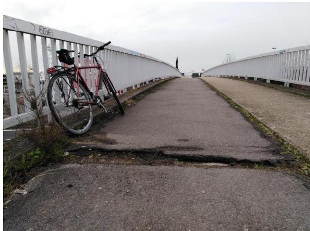
Fissures au-dessus du joint de dilatation
